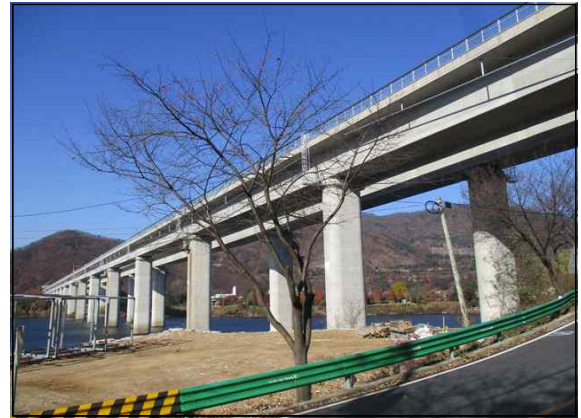
거더 외부 전경
