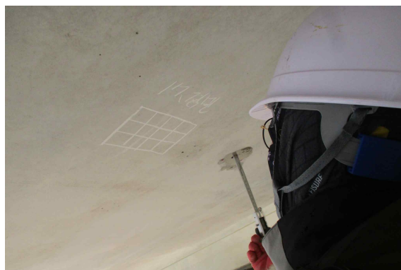
거더외부 탄산화 시험
