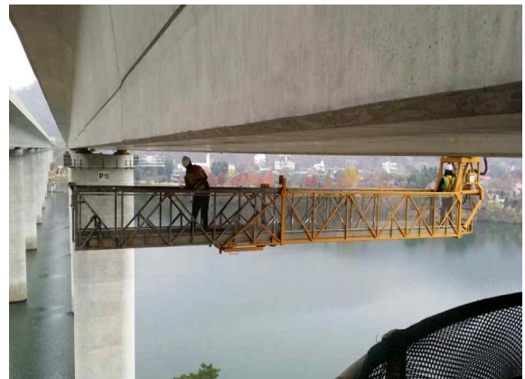
작업차량(굴절차)을 이용한 외관조사②
