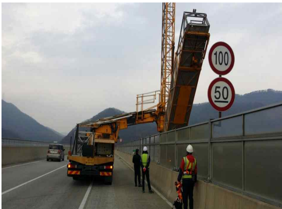
작업차량(굴절차)을 이용한 외관조사①
