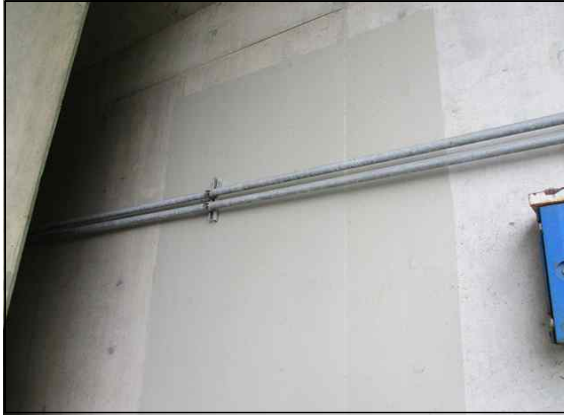
교대 균열보수 현황(A1)
