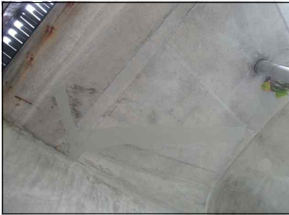
바닥판 균열보수 현황(S1)
